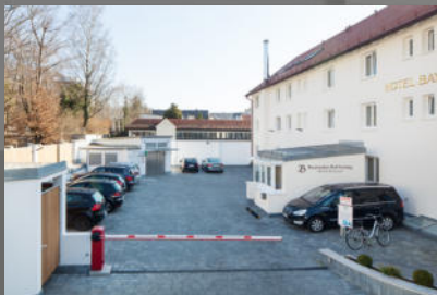
Rückansicht des Hotels, unterhalb der Parkfläche liegt die 2-geschossige TG
