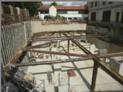
Baugrubenaussteifungen
