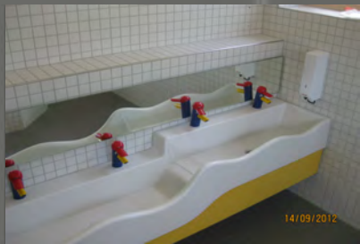
Washbecken in den Toiletten
