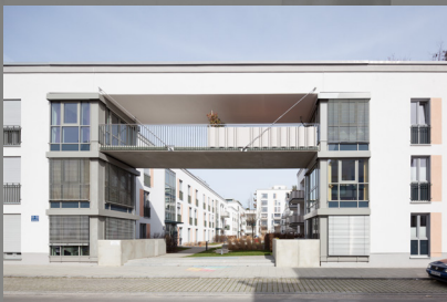
Blick in den Innenhof mit Verbindungsbrücke
