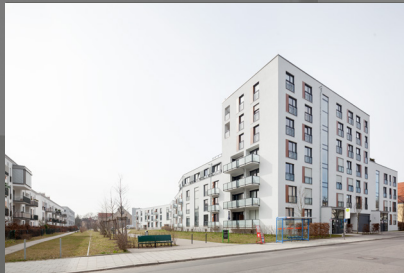
Seitenansicht von der Straße
