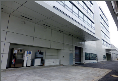
Osteingang mit Tanksäulen
