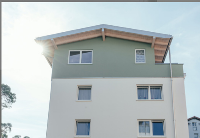
Detailansicht der Aufstockung
