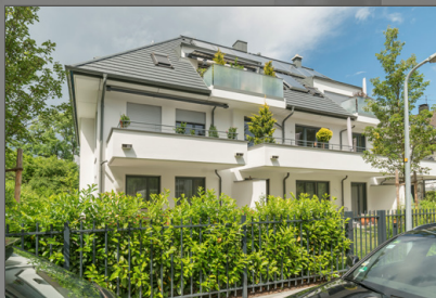
Balkonansicht vom Gehweg
