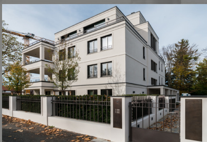
Ansicht vom Gehweg
